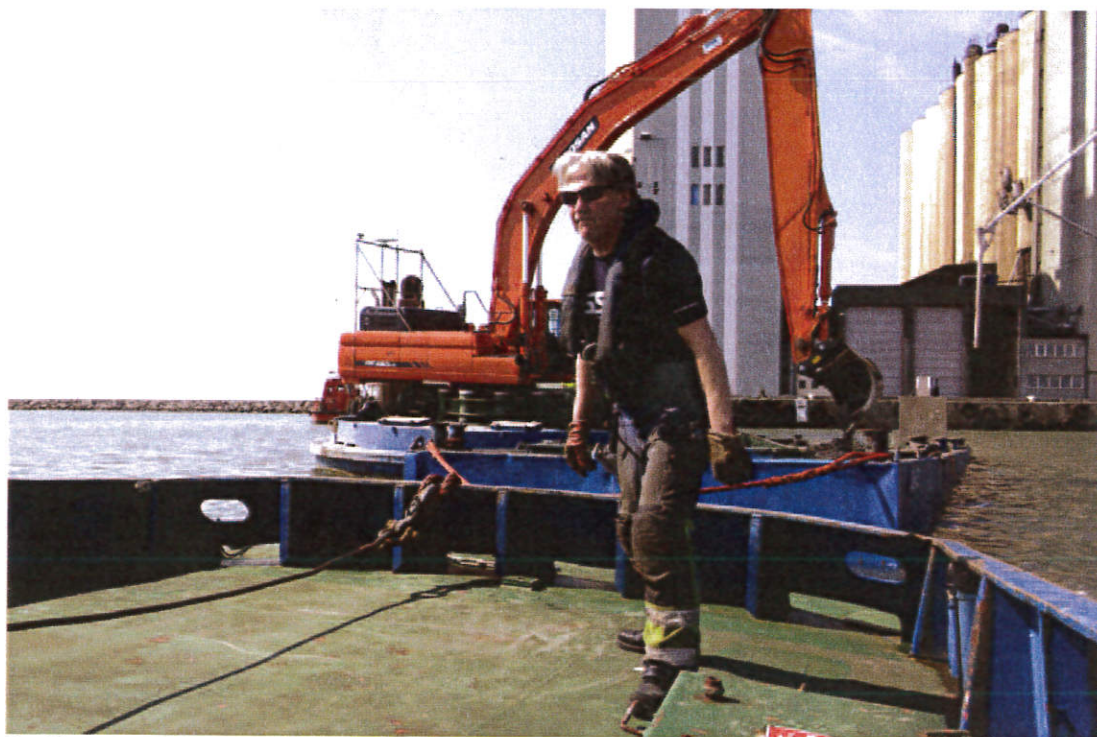
Bernt Månsson fäster pråmen med 70 kubikmeter sand – cirka 100 ton – på bogserbåten som ska ut i havet och dumpa muddermassorna.
