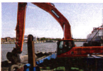
Med grävskopan på Sjögrip kan Peter Jarl hämta upp sediment och sand på tio meters djup. Sjögrip väger 1.39 ton.
